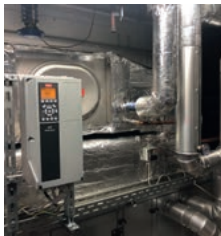
Nachher: Nach dem Bogen montierte Vorrichtung für die Dampfleinbringung
