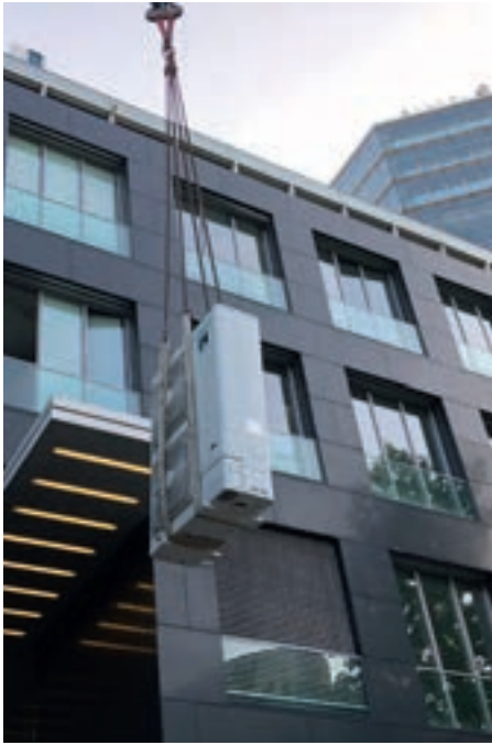
Transport der Außeneinheiten
