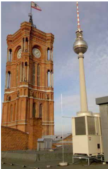
Nach der Farbe der Ziegel hat das historische Gebäude in der Nähe von Fernsehurm und Spree den Namen "Rotes Rathaus" erhalten.
