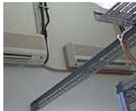
Die Wandgeräte in den IT-Knotenpunkten des Hauses ließen sich problemlos montieren.
