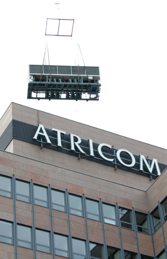
Gerätetransport auf das Gebäudedach
