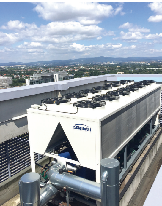
Einlass des Kaltwassersatzes in die vorhandenen Anschlüsse
