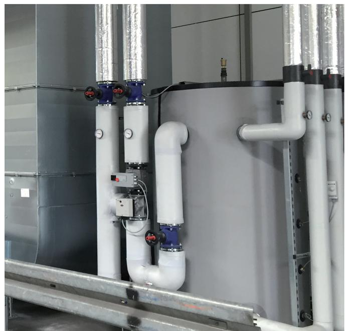
*Der als hydraulische Weiche eingesetzte 1500 L Pufferspeicher*
