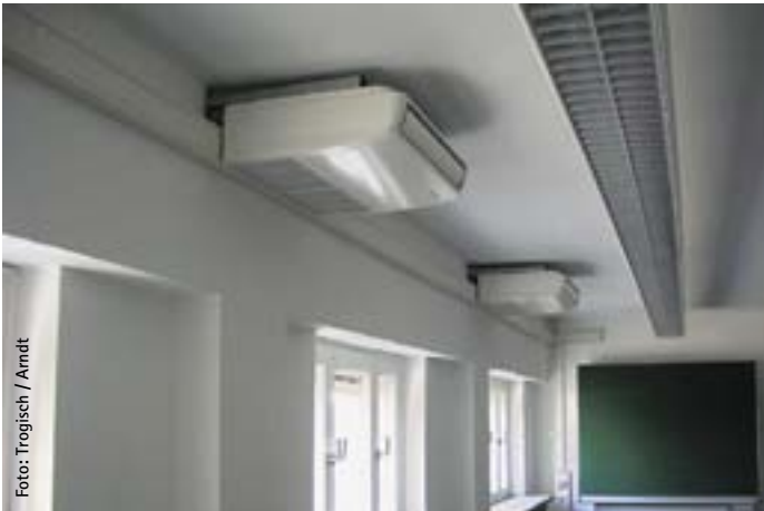
Bild 4 Einsatz von Unterdeckengeräten in einem Seminarraum (links falsche, rechts richtige Anordnung)
