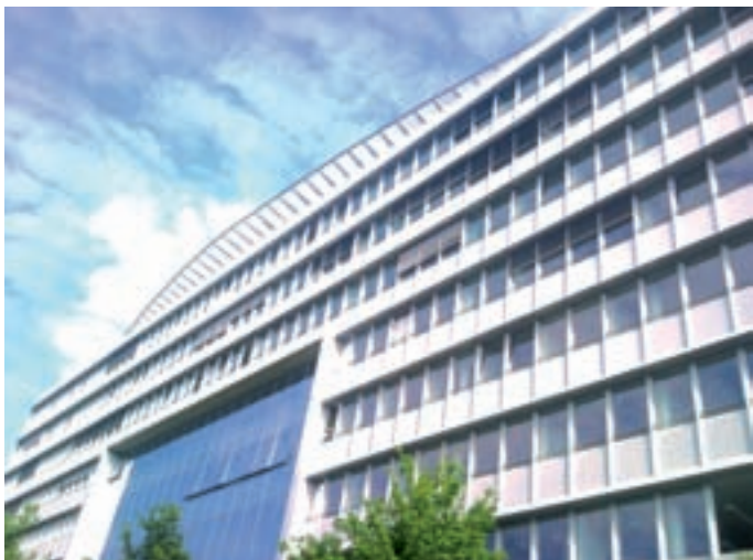
Im Zuge von Renovierungsarbeiten wurden im Verlagshaus Handelsblatt zwei Etagen klimatisiert.
