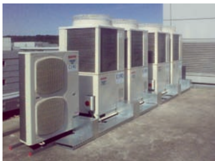
Die Montage ist abgeschlossen. Jeweils zwei Außeneinheiten sind modular miteinander verbunden.
