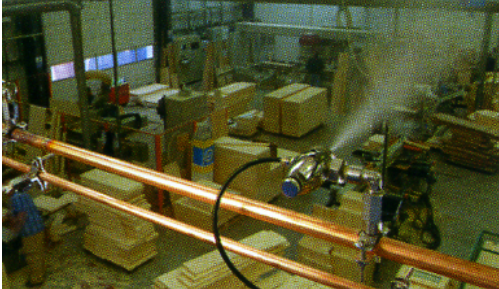
Abb.9: Zweistoffdüsenanlage in der Holzindustrie (Werkbild KAUT)
